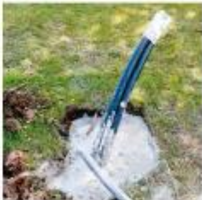
Füllen des Bohrloches mit wärmeleitendem Beton
