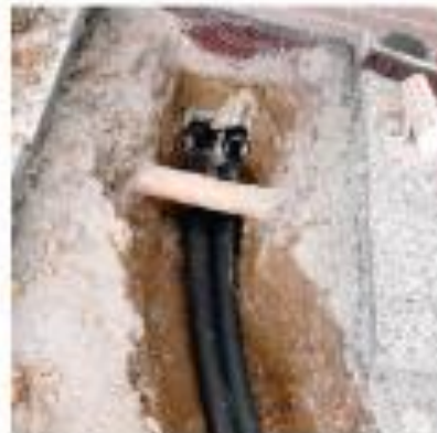
Einarbeiten zur Verlegung der Anschlussleitungen
