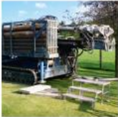
Zufahrt des Bohrgeräts
