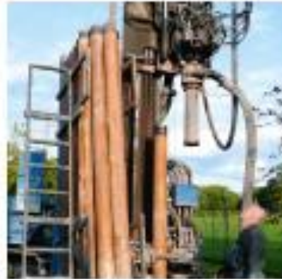
Beginn der Bohrung
