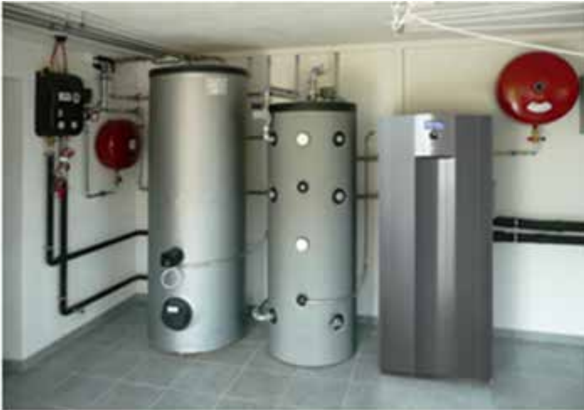
Erdsonden Wärmepumpe
