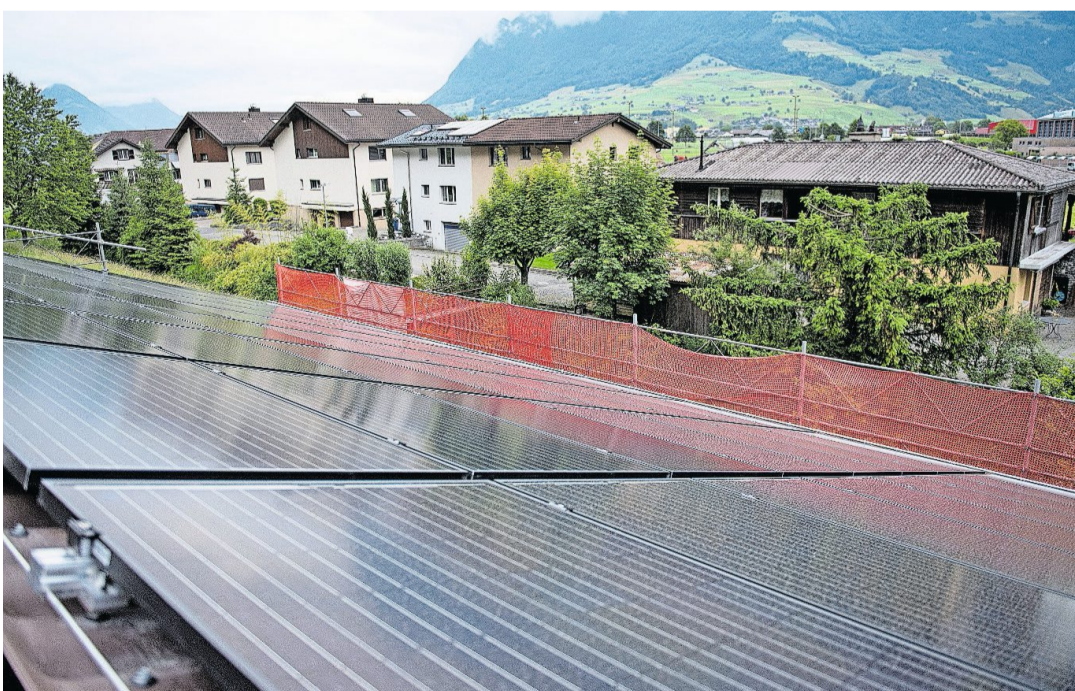
Auch Solaranlagen auf Hausdächern (hier in Stans) sind an der Messe Thema.
